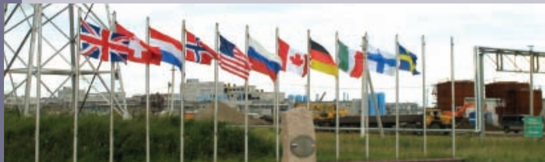
Вход на завод по уничтожению химического оружия в городе Щучье
