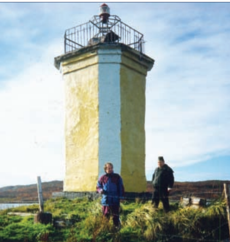
Маяк, питаемый радиоизотопным термоэлектрическим генератором (РИТЭГ), содержащим высокорadioактивный материал. Фотография предоставлена губернатором провинции Финмаркен (Норвегия)
