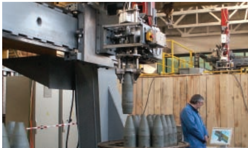
Манипуляторы для второго главного производственного корпуса завода по уничтожению химического оружия в городе Щучье
