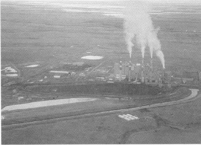
Centrale thermique Boundary, avril 1991 (photo : R. Riewe).
