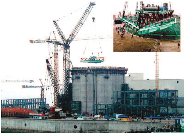
L'utilisation de la méthode de construction sans toit a permis de réduire les délais d'installation du système d'arrosage de six mois à cinq jours.
