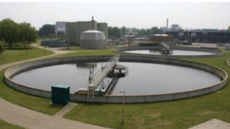
Station de traitement d'eau
