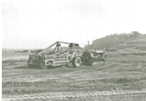
Des pistes ont été asphaltées en préparation de l'effort de guerre et de l'accroissement prévu des activités menées à Rockcliffe, octobre 1939. (Archives nationales du Canada PA 63481)
