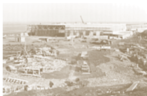
Construction de trois autres hangars du côté sud du terrain d'aviation en 1942. C'est dans ces bâtiments qu'a emménagé la Collection aéronautique nationale après 1964. (Archives nationales du Canada PA 64124)
