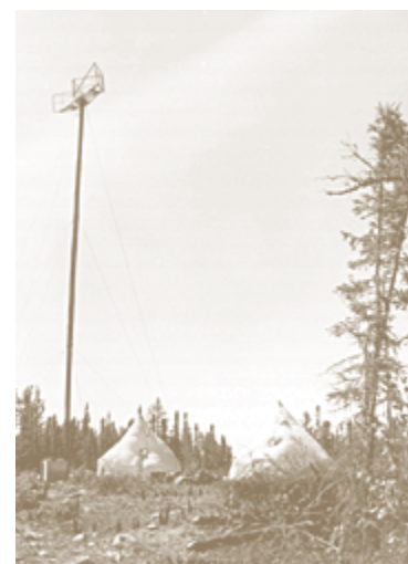
Camp SHORAN et antenne, 1950. Grâce au système SHORAN, des émetteurs installés dans des camps au sol transmettaient des signaux à l'avion pour qu'il puisse se poster correctement au-dessus du terrain à photographier. (Archives nationales du Canada PA 66363)
