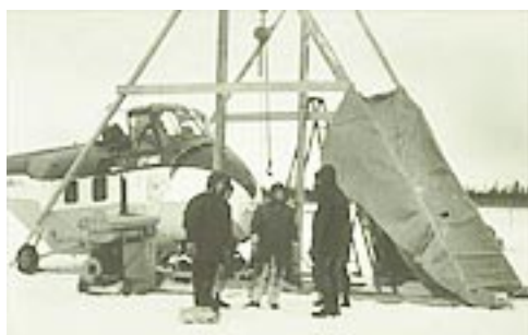
Entretien et réparation d'un appareil sur le terrain
