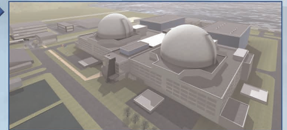
Artist's impression of a 2-unit ACR-1000 GEN III+ Nuclear Power Plant: 1200 MWe class Illustration d'une centrale nucléaire à deux tranches de Génération III+ ACR-1000 du palier 1 200 MW(e)
