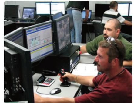
*Les opérateurs du transporteur à outils de remplacement de tubes de force se trouvent dans le centre de commande de remplacement des tubes de force pendant le retrait des prolongements de canaux de la tranche 2, lequel est effectué au moyen d'outillage commandé à distance.*
