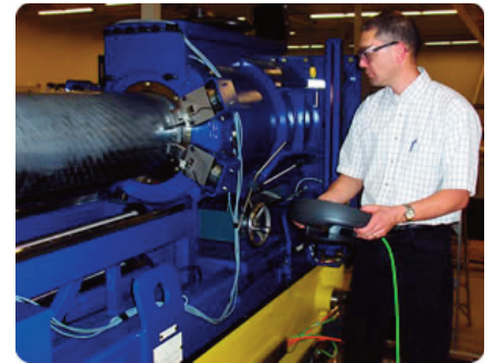
Dave Morikawa, le chef technique d'EACL, Outils de remplacement des tubes de force, exploite le système d'extraction des prolongements de canaux et des bouchons de protection qui est en cours de fabrication à Cambridge.
