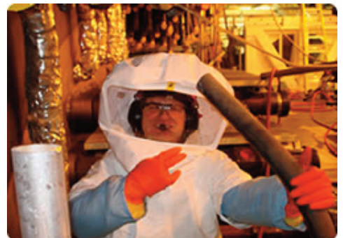
Stephen Rothdeutsch, chaudronnier avec la dernière section inférieure des tubes de liaison coupées et enlevées de l'enceinte de la tranche 2.
