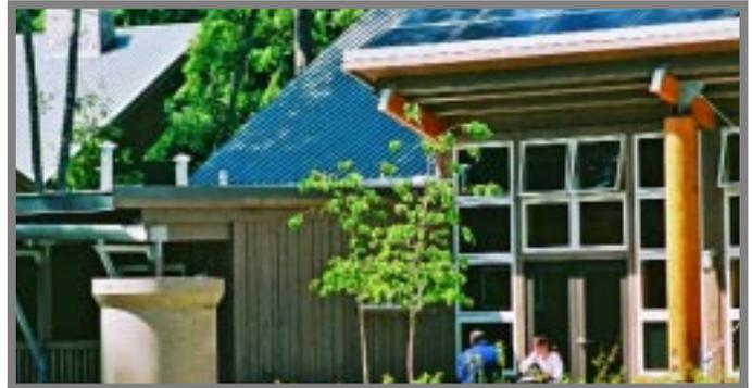
La firme **KEEN Engineering** a conçu l'immeuble du centre d'apprentissage écologique d'Islandwood à Washington — quatrième projet certifié « or » par le système d'évaluation LEED dans le monde. C'est grâce à l'écocartographie, à l'orientation, à la forme et à la configuration du site de l'immeuble, à la cartographie thermique, à la ventilation naturelle et à d'autres méthodes et principes que ce projet a pu se qualifier pour la certification « or » du système LEED. (Photo : Keen Engineering)
