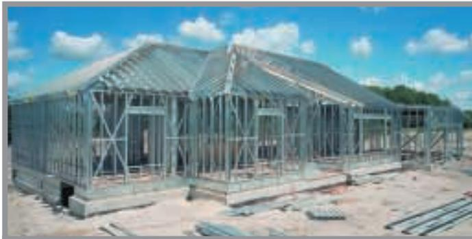
*Des produits en acier pour tous les éléments d'ossature de la maison : poteaux de murs, solives de planchers et fermes de toits faciles à assembler et contribuant à créer une ossature en acier solide, qui résiste au feu.*
