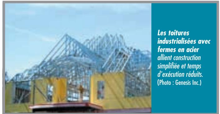
*Les toitures industrialisées avec fermes en acier allient construction simplifiée et temps d'exécution réduits.
