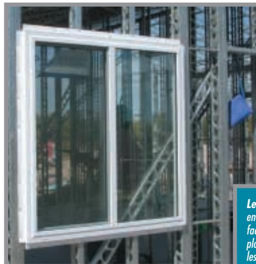
*Les systèmes d'ossature en acier léger reçoivent facilement le câblage, la plomberie, les fenêtres, les portes et l'isolant. (Photo : Mission Homes)*
