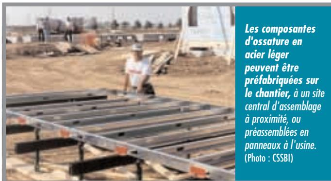
*Les composantes d'ossature en acier léger peuvent être préfabriquées sur le chantier, à un site central d'assemblage à proximité, ou préassemblées en panneaux à l'usine. (Photo : CSSBI)*
