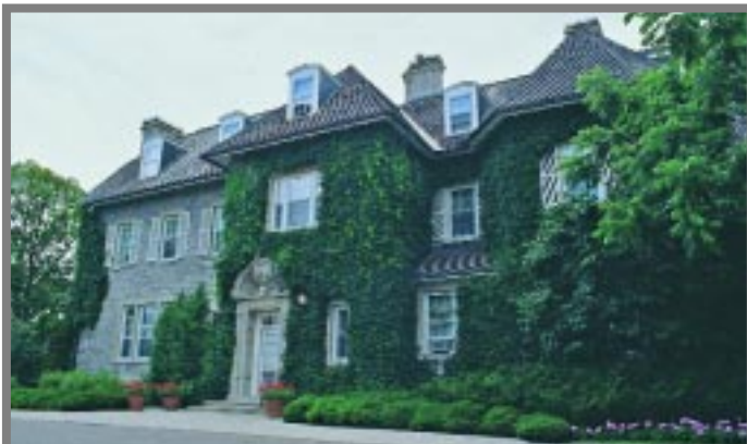
La résidence officielle du Premier ministre du Canada arbore fièrement une magnifique toiture recouverte de bardeaux de cèdre rouge.
