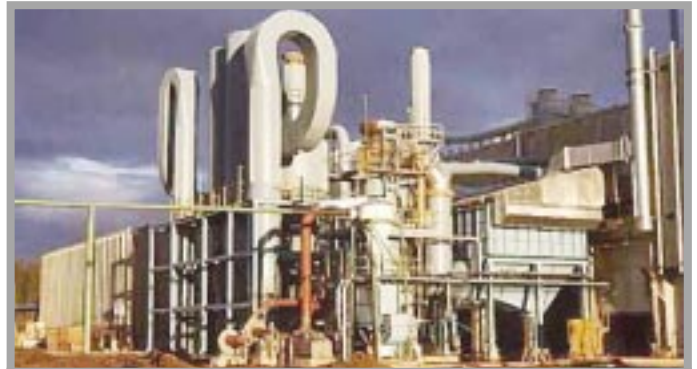
Dispositif de combustion à deux étapes pour l'alimentation de sécheurs éclair d'une usine de pâtes et papiers en Nouvelle-Zélande.
