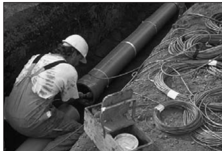
Mesure de la magnitude des forces sur les conduites principales
