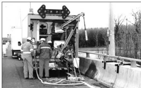
Carottes prélevées sur un parapet de pont en béton pour analyse en laboratoire
