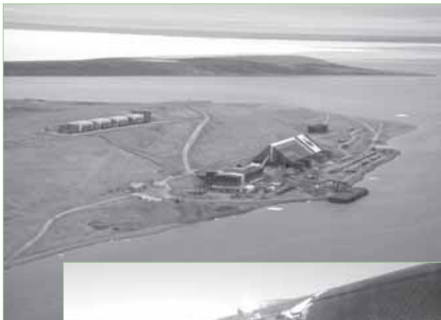
Exploitation de la mine
