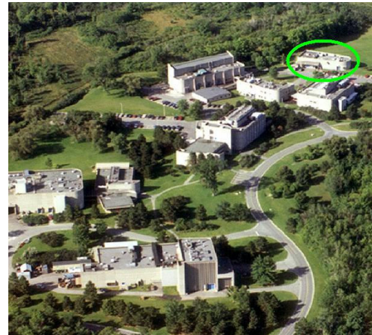
Installations de recherche du CTEC du complexe de Bells Corners (Ont.); l'emplacement de l'installation d'essai (bâtiment n° 7) est encerclé
