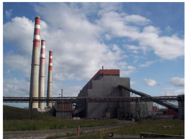
Centrale électrique à charbon
