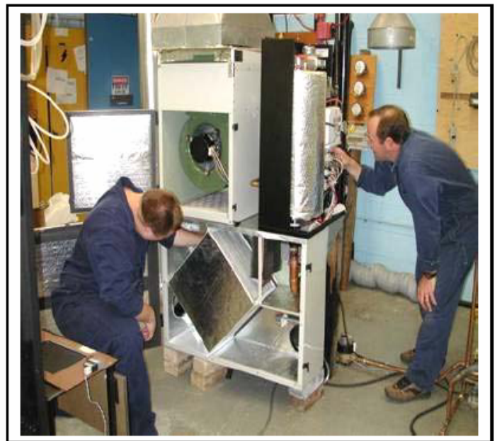
Laboratoire de combustion haute efficacité
