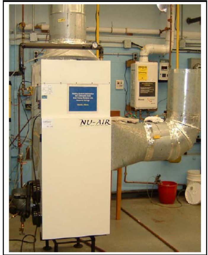
Ventilo-convecteur Drake Landing - Okotoks
