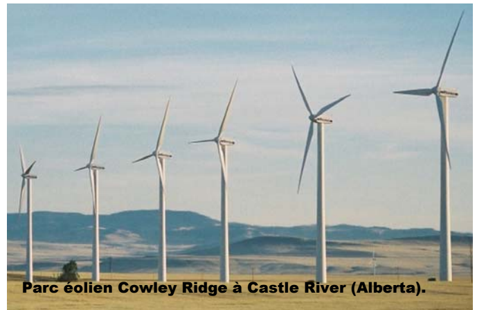
Parc éolien Cowley Ridge à Castle River (Alberta).
