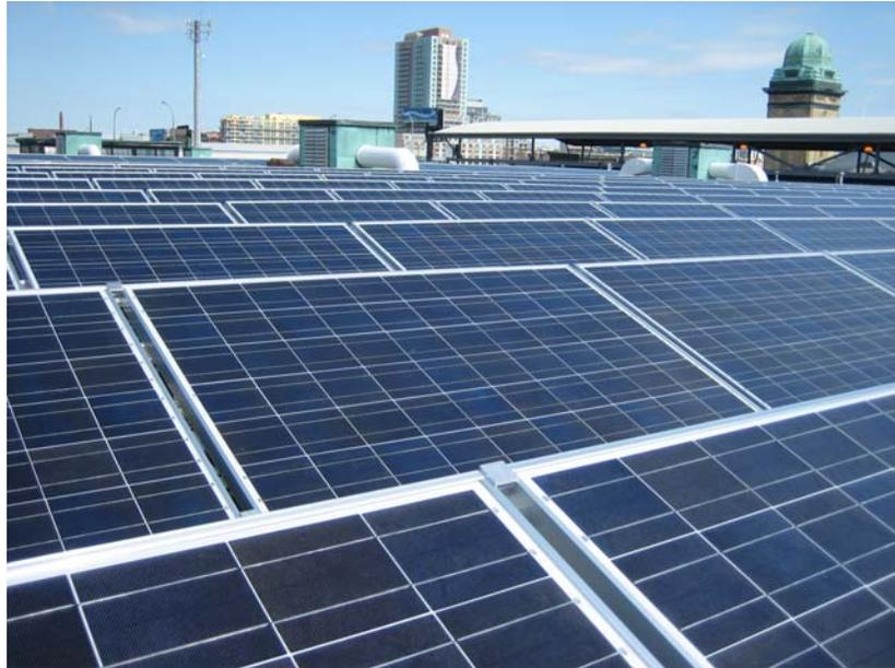
Figure 1 : Système PV de 1100 kW installé sur le toit à l'Exhibition Place, Toronto (Ontario) Canada. (Photo : Exhibition Place)
