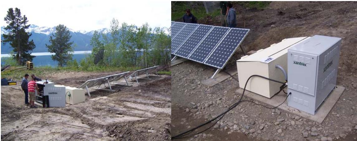
Figure 3 : Le système d'alimentation hybride de Xantrex permet de diminuer la consommation de combustible classique des génératrices par les Premières nations et accroît la fiabilité des systèmes dans les régions éloignées (Photo : Xantrex)
