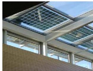
**Figure 2 : Systèmes installés dans le puits de lumière de l'immeuble Fred Kaiser (UBC), C.-B. et système PVIB de 7 kW raccordé au réseau (Photo : Carmanah)**
