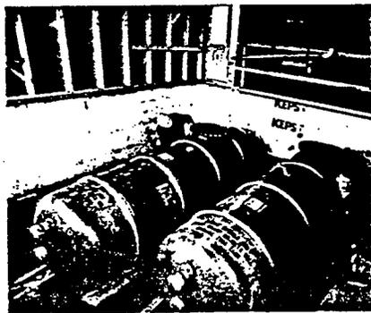
Un senseur situé dans le réservoir détecte la présence d'eau chaude. Il active alors une pompe qui fait circuler le glycol réchauffé vers les deux réservoirs de stockage.
