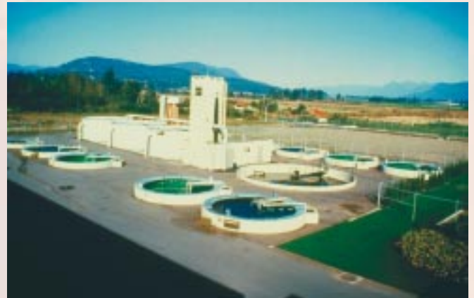
Les installations de traitement des eaux figurent parmi les nombreux projets d'infrastructures « verts » mis en chantier dans l'Ouest canadien.
