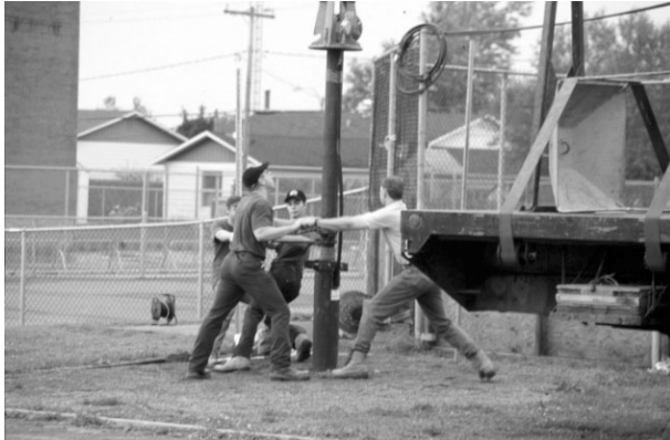
Installation d'une pompe à eau à grand débit dans le puits de production pour effectuer des essais de nappe aquifère, au nord de Montréal.
