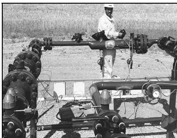
Mesure de la corrosion sur le terrain
