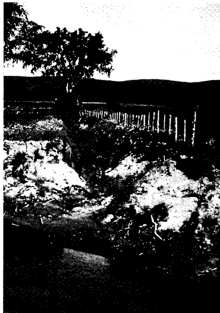
L'érosion des berges favorise la contamination des cours d'eau par les polluants agricoles.
