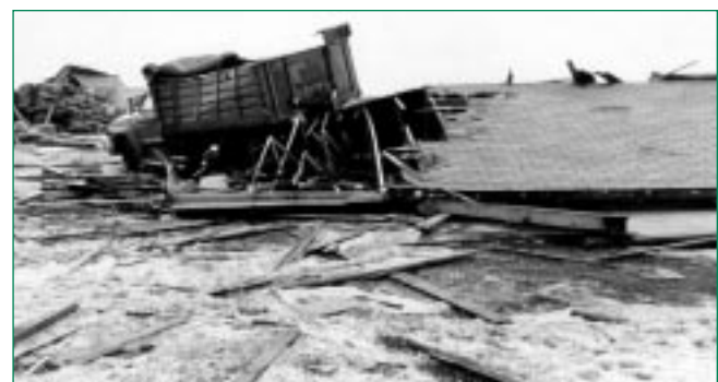
Dommages faits par une tempête de vent
