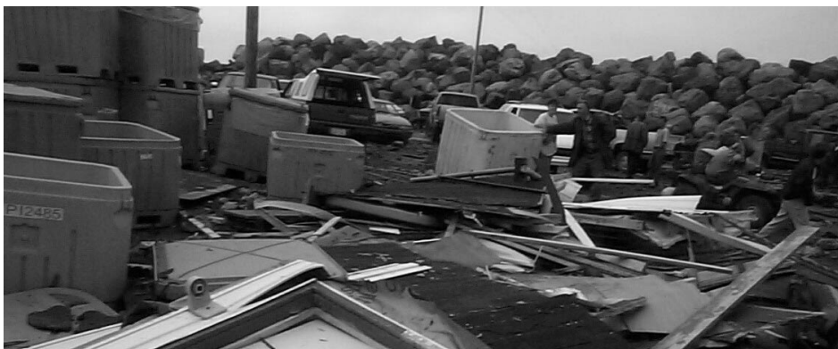
On évalue les dégâts causés par la tempête au port de St. Bride.
