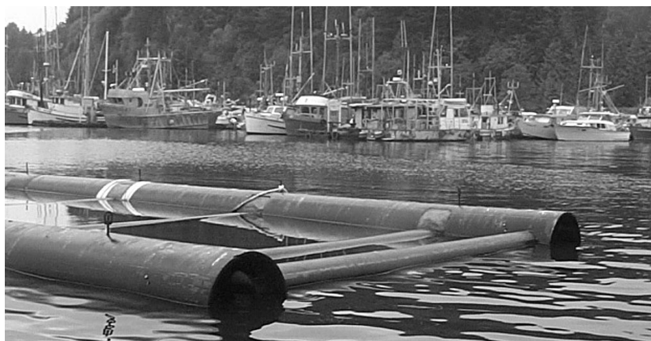
Le brise-lames de 280 mètres ancré à son poste au port Rushbrooke, à Prince Rupert, a remplacé un brise-lames en paquets de billes mal en point qui n'avait duré que neuf ans.
