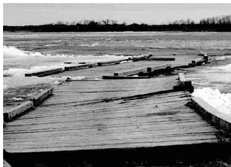
Le quai de Duck Bay, avant sa reconstruction.
