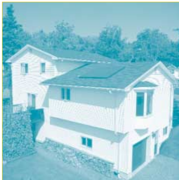
▲ Des capteurs plats vitrés installés sur une maison en Nouvelle-Écosse.
