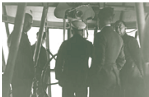
Quelques officiers et passagers dans la nacelle de commandement
