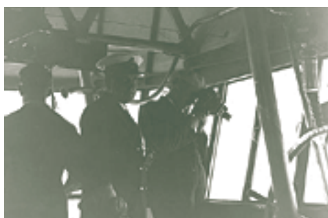
L'intérieur de la nacelle de commandement
