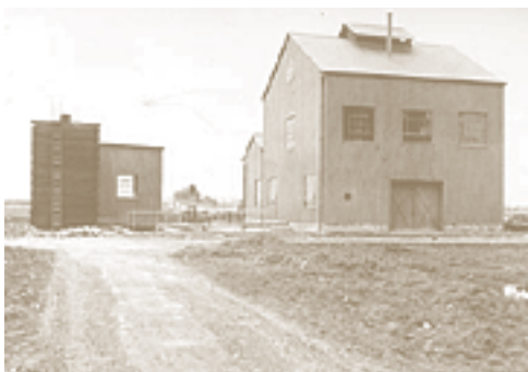
Quelques-uns des bâtiments à Cardington
