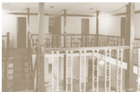
L'étage supérieur surplombant la salle à manger
