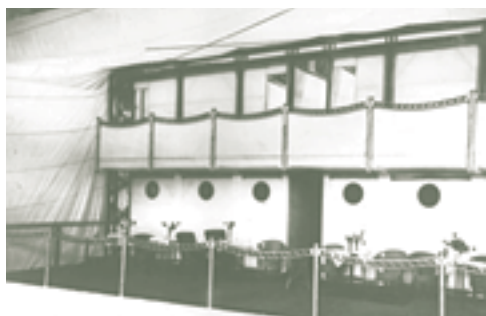
Les balcons promenades inférieur et supérieur à bâbord du R.100
