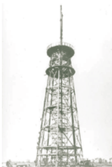
Construction du mât d'amarrage à Saint-Hubert
