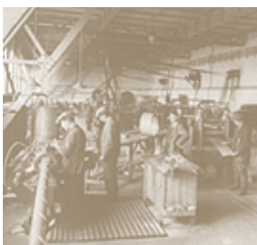
Construction du R.100 à Howden
