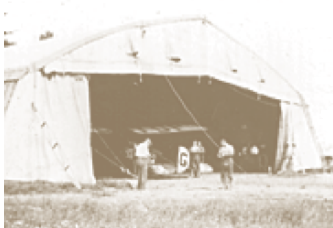
Photographie prise en 1921 du premier hangar à Rockcliffe, l'un des hangars de toile Bessonneau, donnés par la Grande-Bretagne au Canada en 1920. À l'entrée, un chasseur Bristol F.2B. (Archives nationales du Canada RE 18027)
