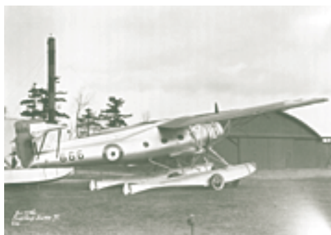
Un Fairchild Super 71 de l'ARC, le premier aéronef à être construit au Canada avec un fuselage monocoque entièrement métallique, Rockcliffe, 1936. (Archives nationales du Canada PA 63184)
