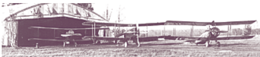
Le hangar de toile Bessonneau, à Rockcliffe, vers 1922 : à l'entrée, un Bristol F.2B, et à l'extérieur, un de Havilland DH-4 et un Avro 504K. (Archives nationales du Canada PA 62272)
