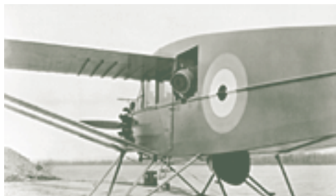
La mise au point des aéronefs, des techniques et des appareils photographiques de reconnaissance s'est poursuivie au cours des années 1920 et 1930. Ici, on peut apercevoir une installation multicaméra dans la cabine d'un Bellanca Pacemaker de l'ARC, Rockcliffe, 1935. (Archives nationales du Canada PA 63075)
