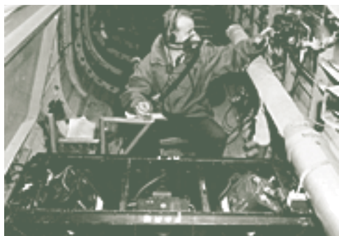
Installation de caméras à bord d'un Avro Lancaster d'une escadrille de photographie aérienne, 1947. (Archives nationales du Canada PA 65920)
