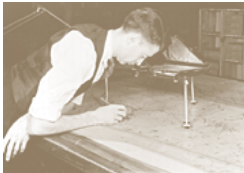
Technicien gouvernemental travaillant à la production d'une carte à partir des clichés trimétrigones pris par un avion de l'ARC, 1945. (Archives nationales du Canada PA 65579)
