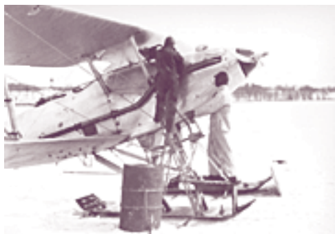
La section d'essai effectuait des vols expérimentaux à l'aide de plusieurs appareils dans les années 1930; ses recherches comprenaient l'analyse de circuits de dilution d'huile pour les démarrages d'hiver ainsi que l'examen de matériel de dégivrage. Ici, un Hawker Audax fait le plein au cours d'essais d'hiver à Rockcliffe en 1934. (Archives nationales du Canada PA 62978)
