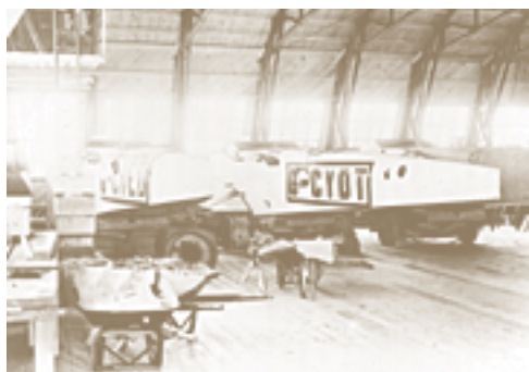
Vue intérieure du hangar reconstruit en bois et de la coque d'un hydravion à coque Curtiss HS-2L, Rockcliffe, 1922. (Archives nationales du Canada PA 62292)
