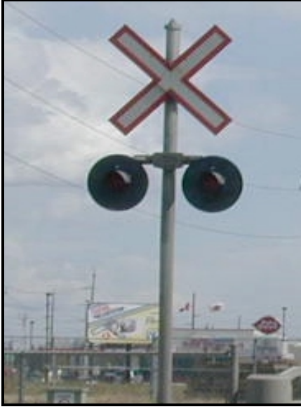
Figure 2.3 Dispositifs d'avertissement automatisés : croix d'avertissement et feux clignotants
