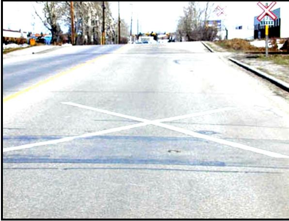
Figure 2.4 Marquage sur la chaussée avant un passage à niveau
