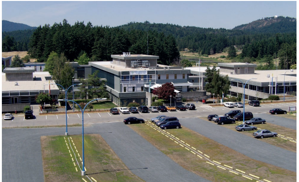
L'installation de 190 000 pi 2 du PTIV.
