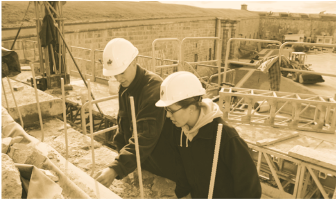
Deux membres du personnel technique de CDC inspectent la maçonnerie de l'enceinte de la Citadelle à Québec.
