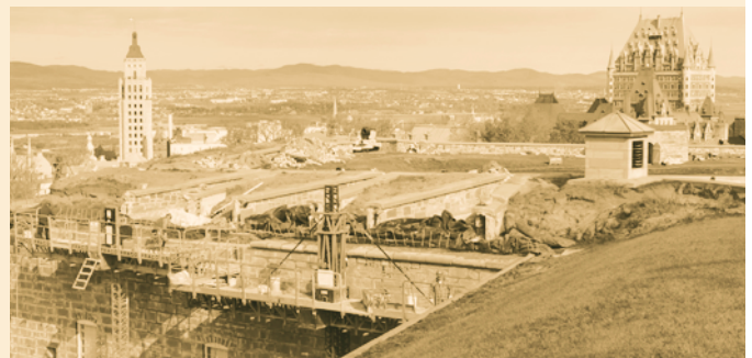
La Citadelle de Québec fait l'objet de travaux d'une valeur de 20 millions de dollars pour la restauration de ses murs. Ces travaux sont exécutés avec la collaboration et l'aide de Parcs Canada et du Bureau d'examen des édifices fédéraux du patrimoine (BEEFP).
