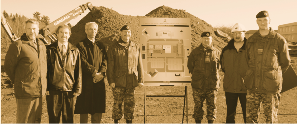
Au mois de novembre 2003, le MDN a annoncé la construction de nouvelles installations de garnison, à BFC Gagetown, pour le 2 e Bataillon, The Royal Canadian Regiment's (2 RCR). CDC assure les services de gestion du marché de ce projet d'une valeur de 11 millions de dollars. Sur la photo, de gauche à droite : Robert Guthrie (Architecte, AMEC), Darrell Stewart (coordonnateur de marchés, CDC), Sia Salehi (gestionnaire de projet, DCPEP 4-2), le Icol Bruce Parks (cmdt, direction du génie, 3 GSS), le Icol R. Turcotte (DCPEP 4), Albert Madsen (gestionnaire de chantier, CDC) et le maj Peter Burgess (RA-DEV 0, 3 GSS).
