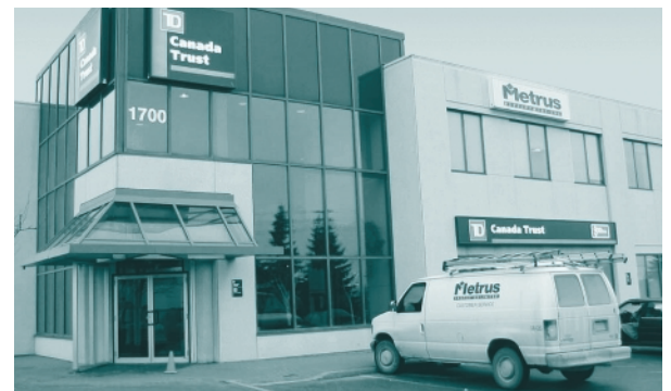
L'édifice Metrus à Concord, en Ontario, est le plus grand immeuble de bureaux de la province à être doté de pompes géothermiques à boucle verticale.
