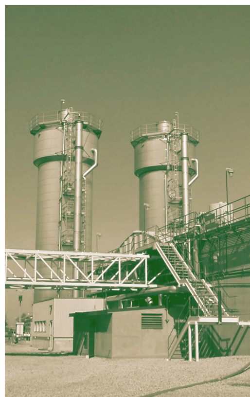
Système de traitement anaérobie ONDEO Degrémont Anaflux® de Casco Inc.
