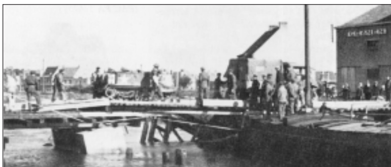
CONVOIS DU GROUPE D'APPUI DE LA 8 E BRIGADE ATTEIGNANT UN PONT DANS EECLOO, OCTOBRE 1944. (ARCHIVES NATIONALES DU CANADA 130262)
