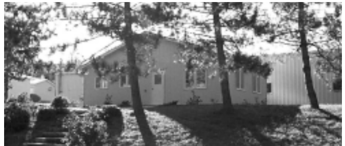
La nouvelle aire de travail, reliée au bâtiment principal par un couloir intérieur, abrite deux bureaux et un grand laboratoire.
