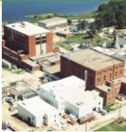
Au premier plan, vue extérieure des bâtiments qui renferment deux nouveaux réacteurs de production d'isotopes MAPLE ainsi que l'installation de traitement associée à Chalk River.
