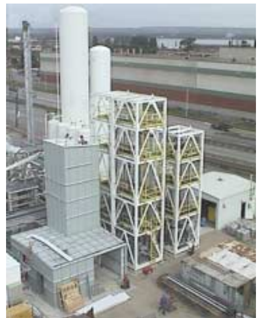
Prototype de l'installation CIRCE (procédé industriel combiné de reformage et d'échange catalytique) pour la production d'eau lourde à Hamilton, en Ontario qui devrait commencer à fonctionner en juin 2000.
