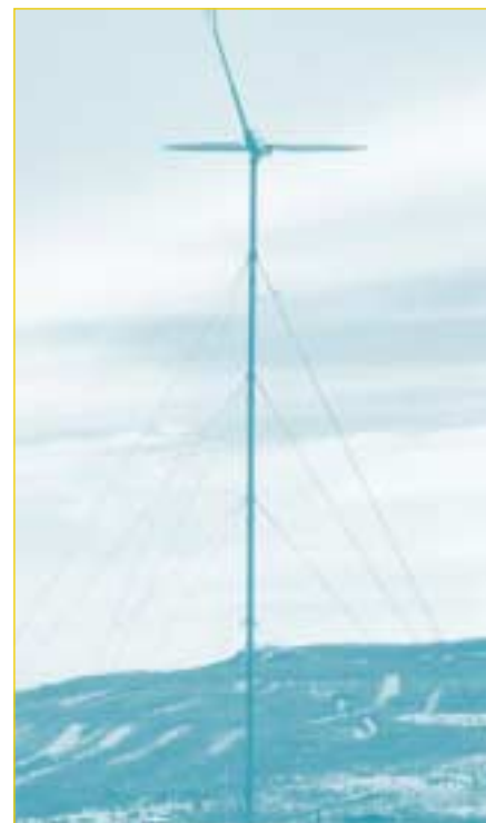
▲ Figure 9. Un petit système éolien de 25 kW Wenvor-Vergnet installé à Collingwood, Ontario, produit de l'électricité pour une maison de campagne. Photographie offerte gracieusement par Wenvor Technologies Inc.
