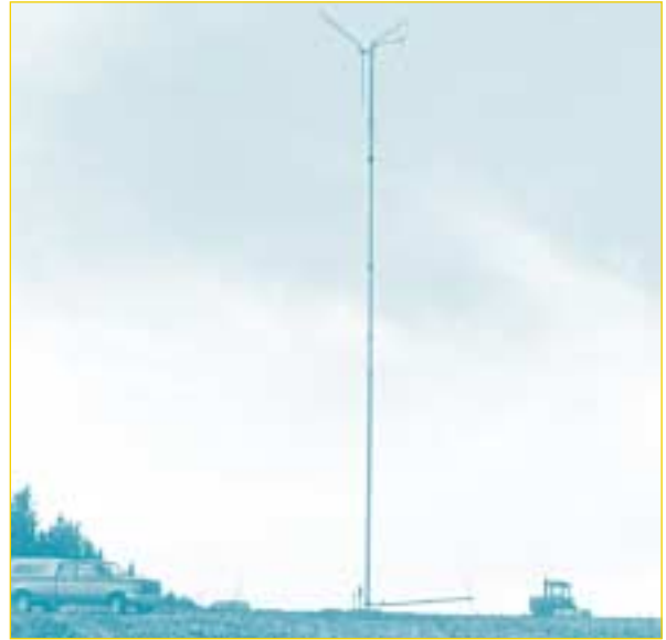
▲ Un système éolien autonome de petite taille peut alimenter en électricité la ferme et la maison du propriétaire (Information et photographie offertes gracieusement par Nor'wester Energy Systems Ltd.)
