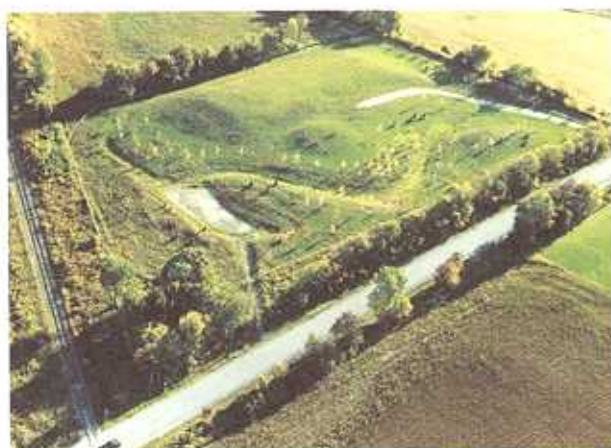
Site de l'avenue Passmore après la construction de la structure de stockage temporaire. (1997)
