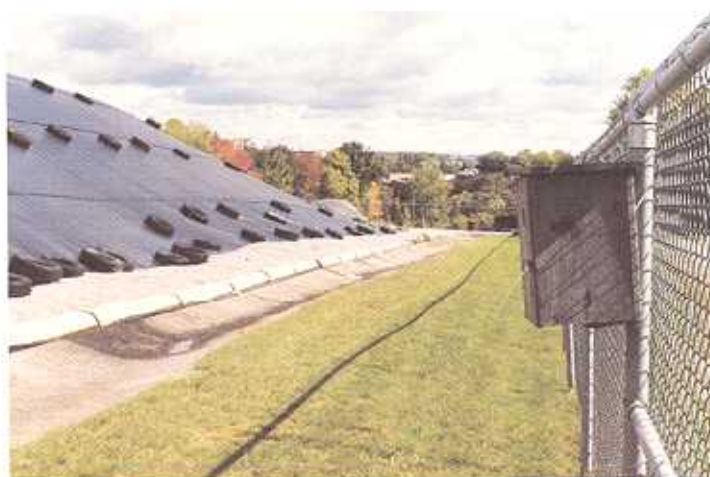
Poste de surveillance environnementale au site de stockage de déchets antérieurs à Port Hope.
