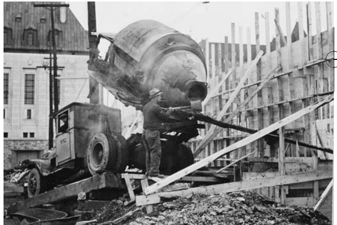
Les travaux de construction débutent en vue de bâtir l'immeuble temporaire numéro 4. Cet immeuble a été conçu pour abriter les effectifs croissants des ministères en temps de guerre.
