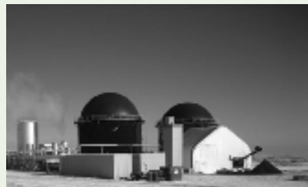
Le fumier est transformé en énergie, en engrais et en eau réutilisable, dans cette installation de traitement du fumier.
