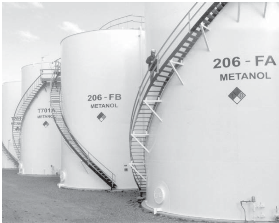
Réservoirs de stockage de méthanol de Methanex
