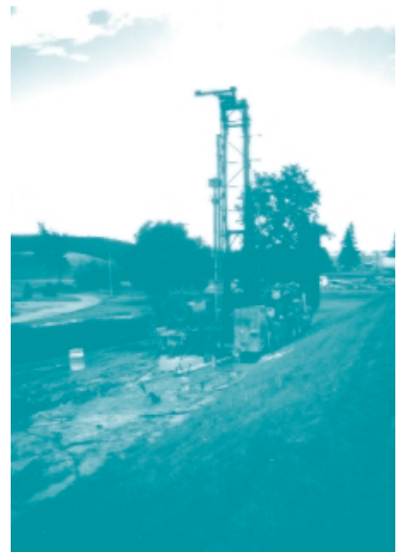
On utilise un appareil de forage pour creuser les trous de forage verticaux.
