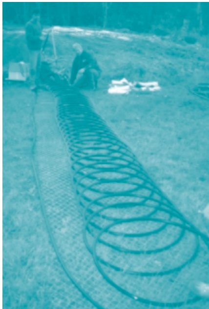
Une boucle en spirale peut être installée sous terre, ou dans un étang ou un lac.
