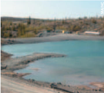
Bassin de polissage. (Mine Giant.)
