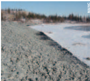
On confine l'eau possiblement contaminée sur le site de la mine. (Mine Giant.)
