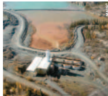
Le bassin de décantation se trouve derrière la station de traitement des effluents. (Mine Giant.)
