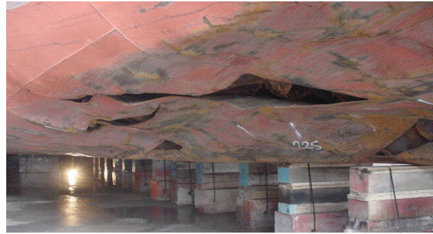
Figure 8. Avaries au double-fond de ballastage n° 1 tribord
