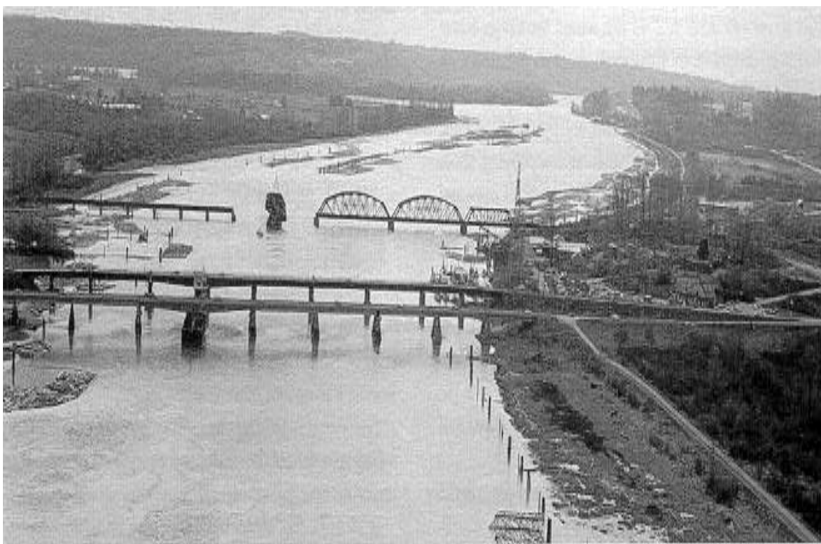
Photo 2. Ponts de la rivière Pitt vue vers l'aval (1986)
