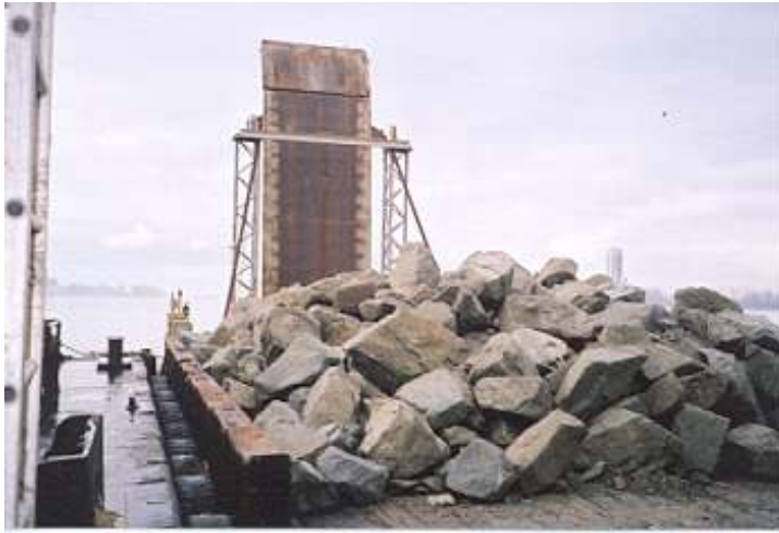
Photo 2. Le chaland Miller 201 avec rampe
