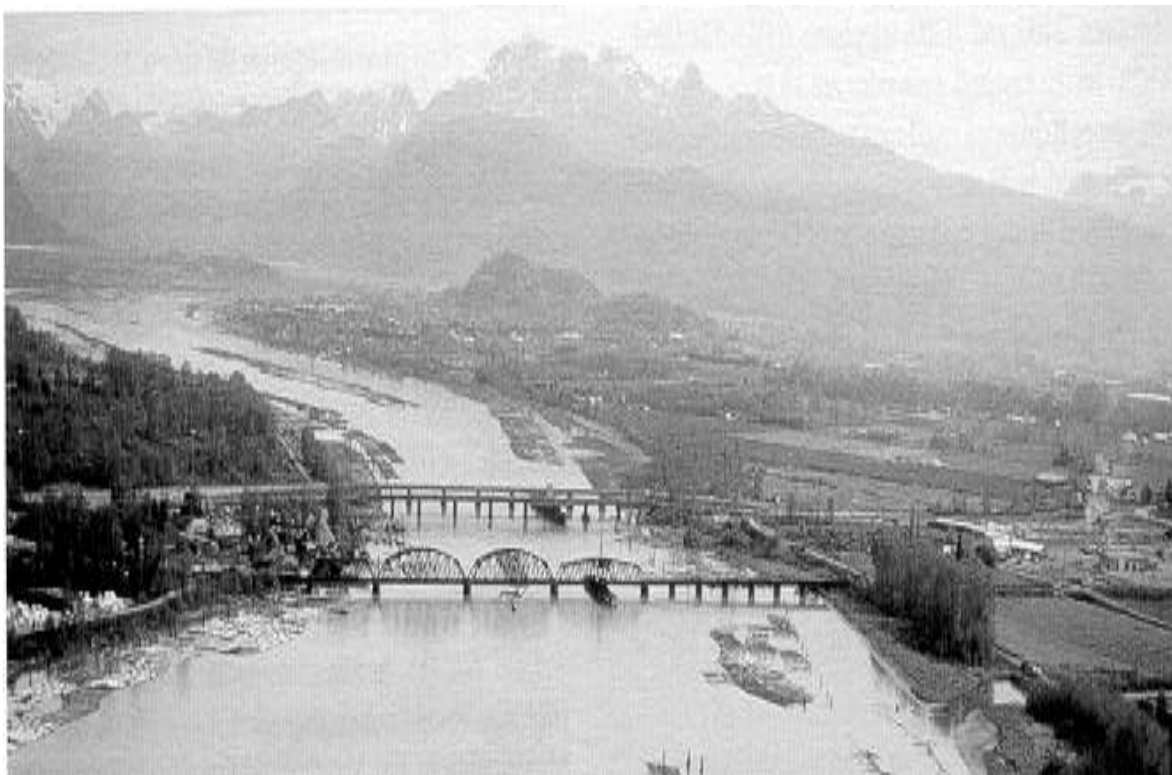
Photo 1. Ponts de la rivière Pitt vue vers l'amont (1999)
