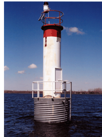
Photo 3. Exemple typique de feu monté sur un caisson.
