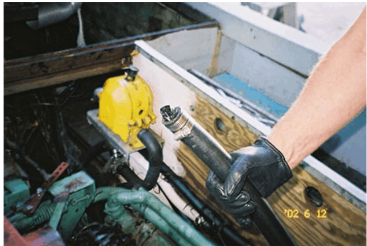
Photo 3. Ruban d'électricien sur le raccord défaillant du tuyau de refroidissement du moteur
