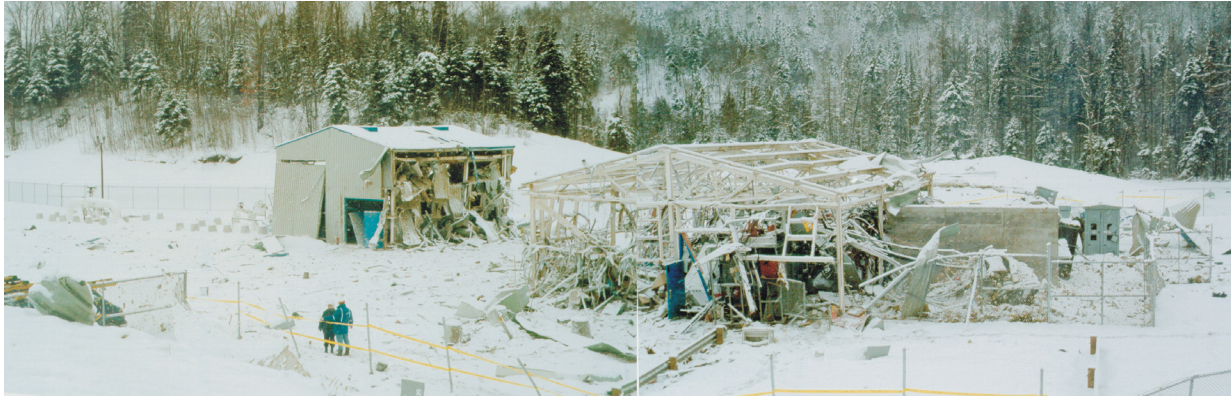
Photo 1. Vue panoramique de la station de compression d'East Hereford (après l'explosion)
